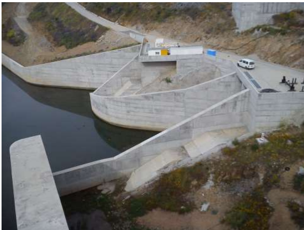
Figura 3: Barragem do Baixo Sabor
